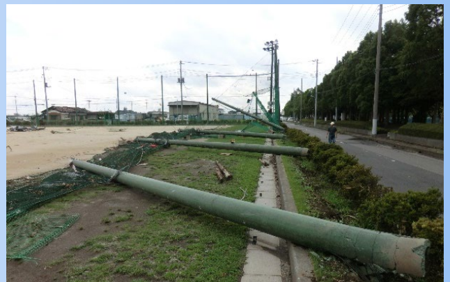
埼玉県越谷市の竜巻被害 2013年
