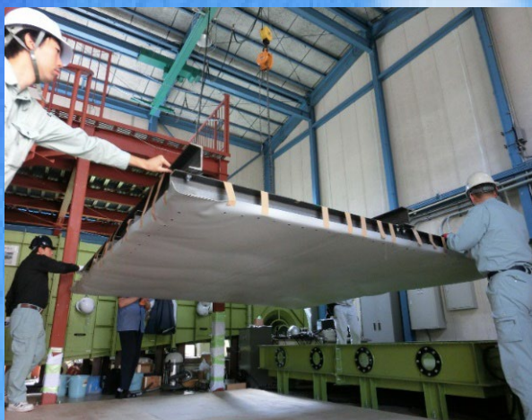
試験体の設置の様子
