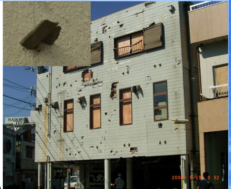
竜巻により屋根ふき材が飛来物として外壁に衝突 (2006年 宮崎県延岡市)
