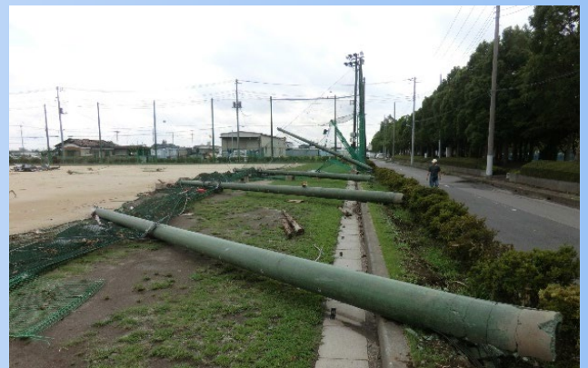
埼玉県越谷市の竜巻被害 2013年
